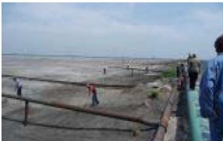
ručna setva trava na nasipima kasete i deponije pepela TE Nikola Tesla B
