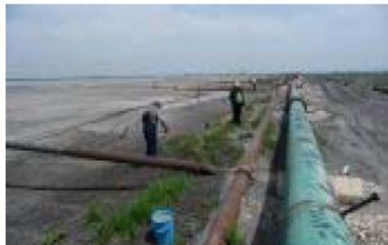
ručna setva trava na nasipima kasete i deponije pepela TE Nikola Tesla B
