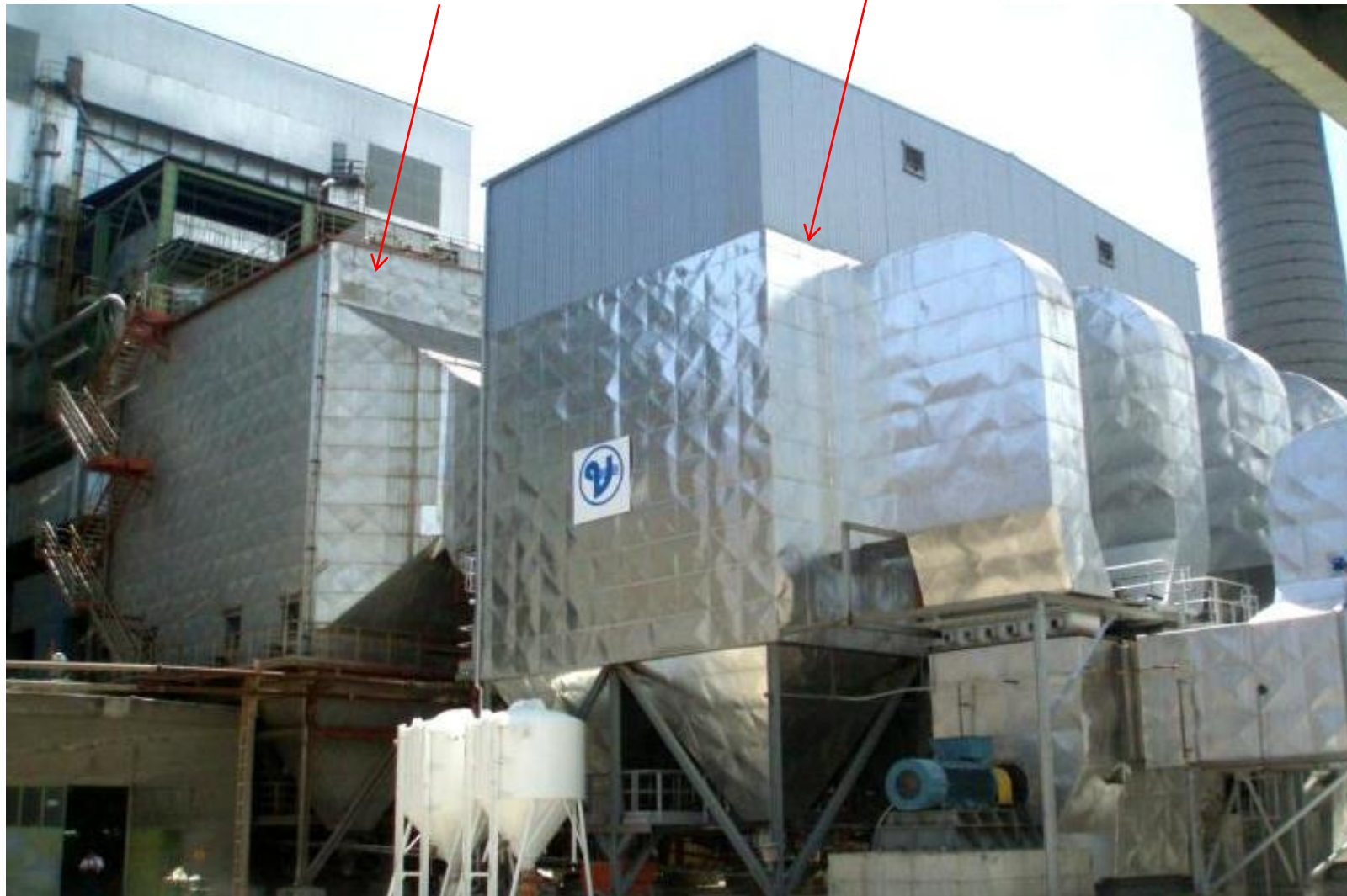
Hibridni filter bloka 5 u Termoelektrani "Kakanj"
