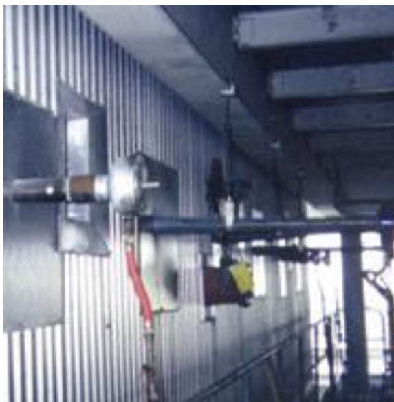
Akustički čistači na SCR katalitičkim komorama
