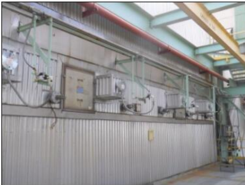
Načini montaže akustičkih čistača na SCR postrojenjima-1
