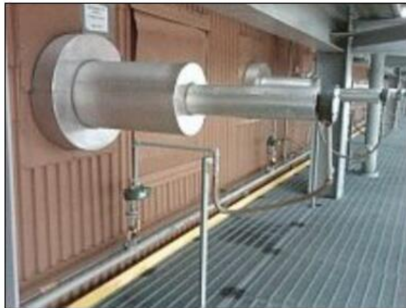
Načini montaže akustičkih čistača na SCR postrojenjima-1
