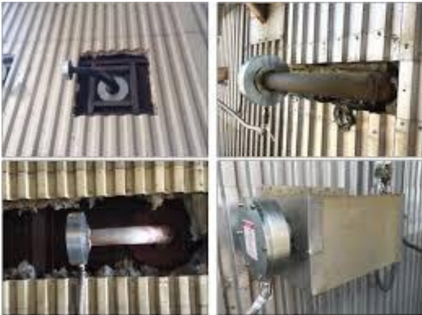
Načini montaže akustičkih čistača na SCR postrojenjima-2
