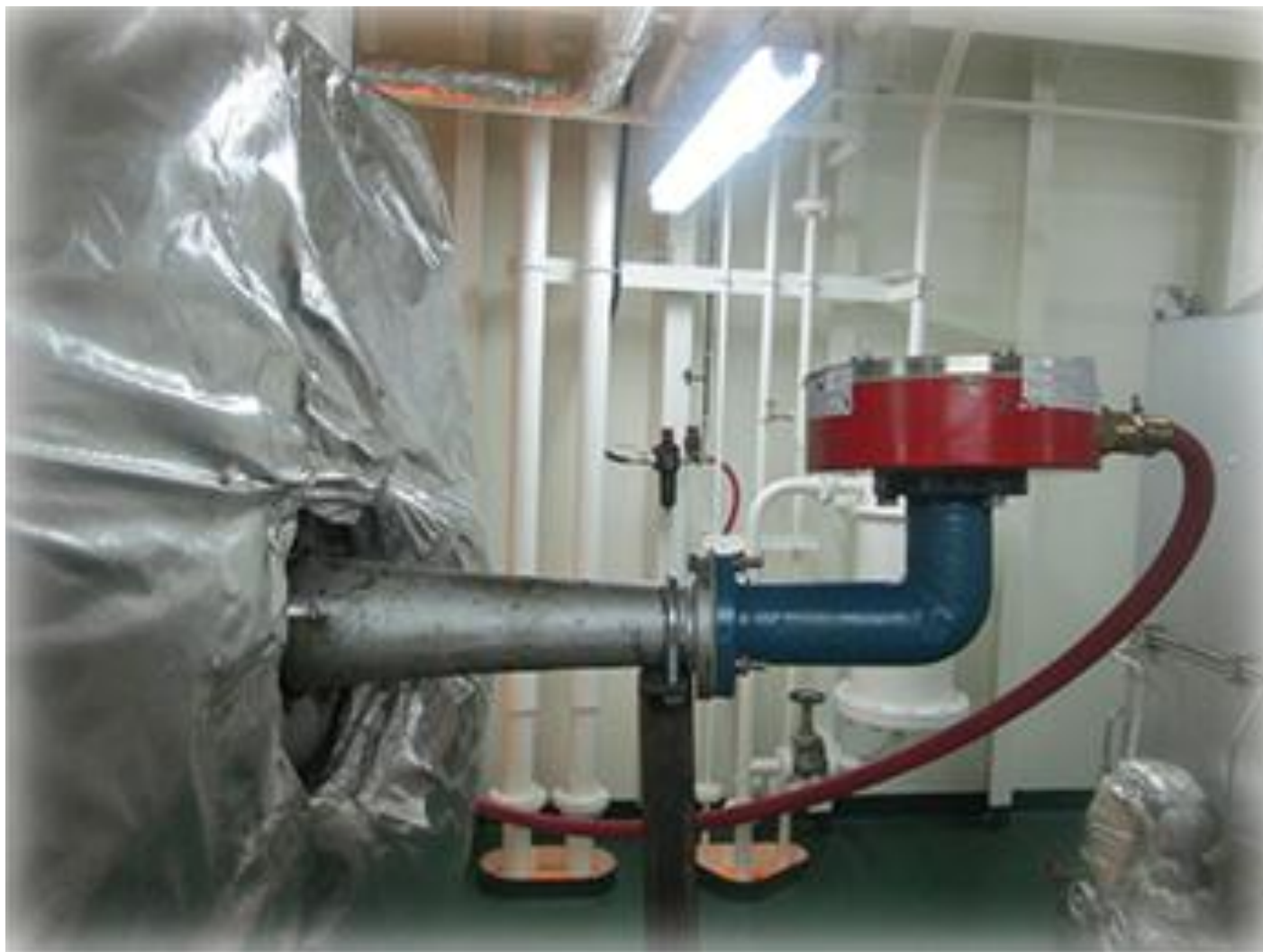
Načini montaže akustičkog čistača na kotlu
