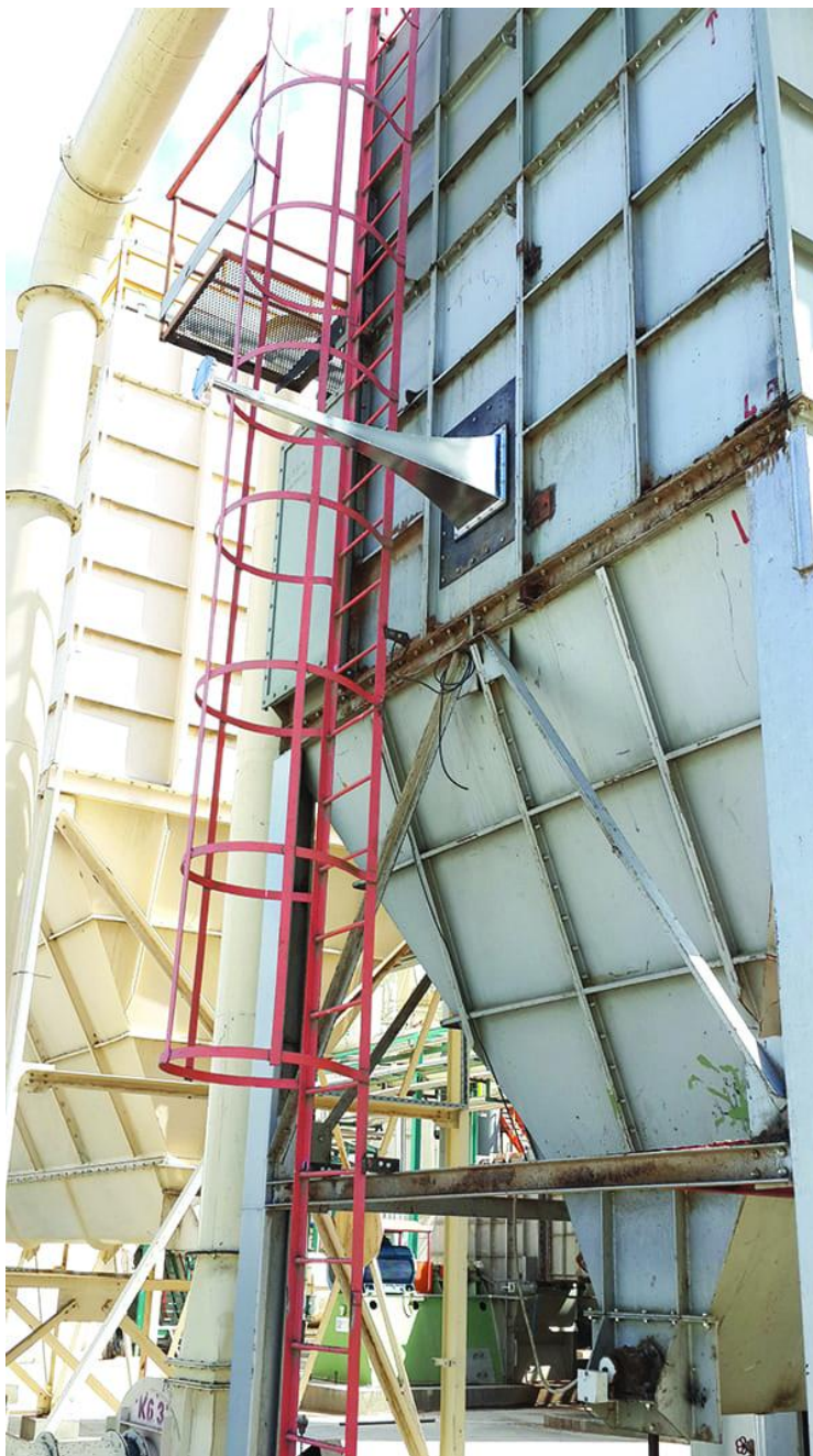
Načini montaže akustičkog čistača na komorama elektrotatičkih Izdvažača
